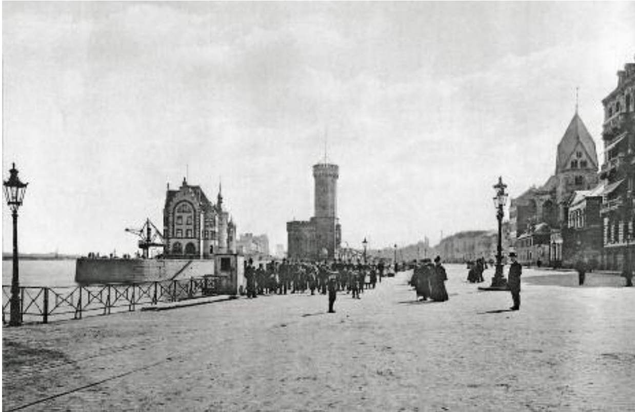
Der Kopf des neuen Rheinaufens mit Malakoffturm und Hafenzollamt; Foto 1898
