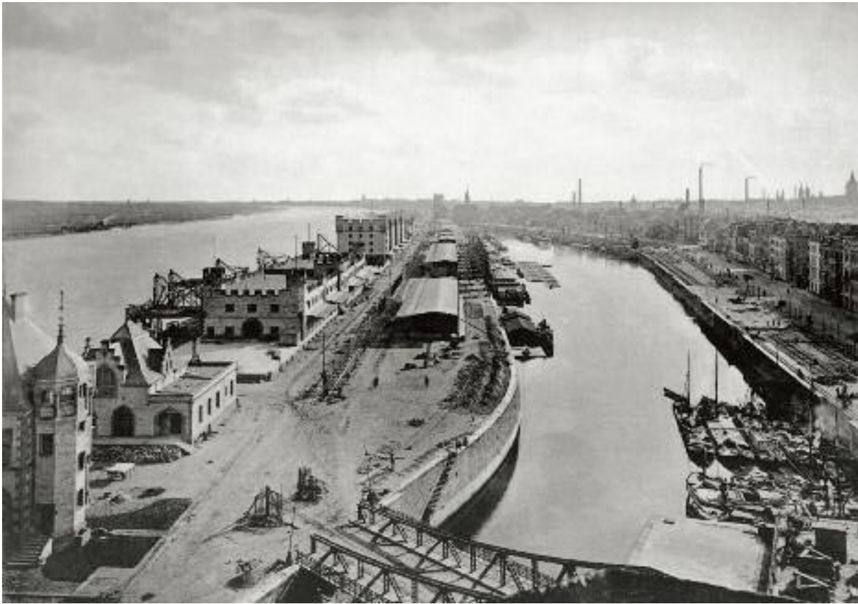
Blick vom Malakoffturm auf den neuen Hafen; Foto R. Dohmen, vor 1898. Maschinenhalle im Krafthaus; Foto Th. Schoenscheidt, 1898
